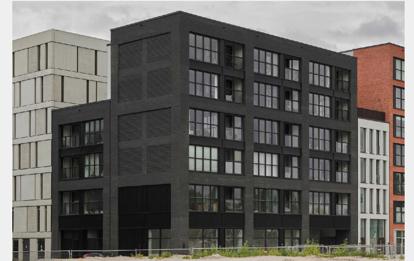
Parkeergarage (links) met appartementen eromheen (Stadscanyon, Amsterdam)
